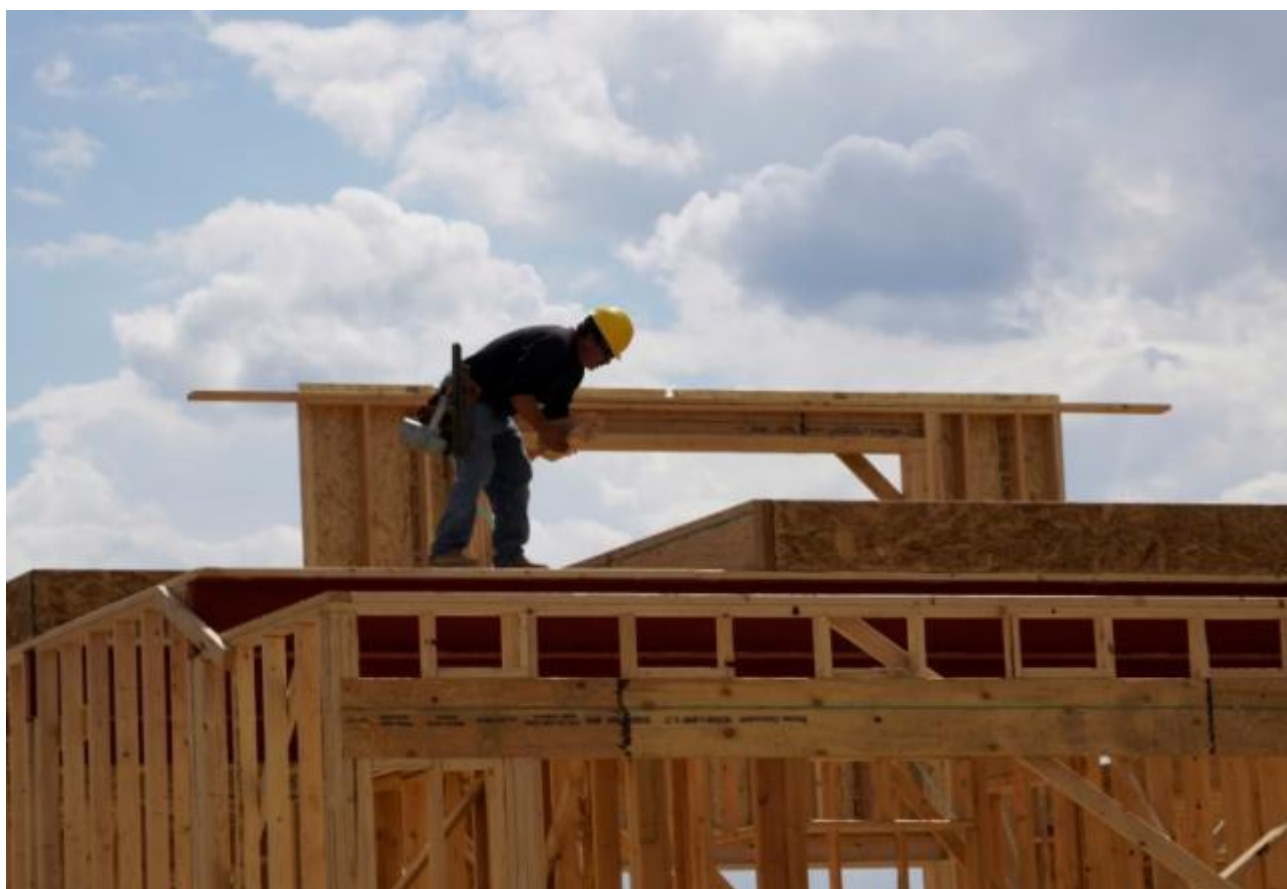
コロラド州アーバダのライデンロックで新築住宅を建設する労働者、2016 年 8 月 30 日
